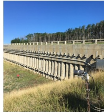
(d) Retaining Wall
